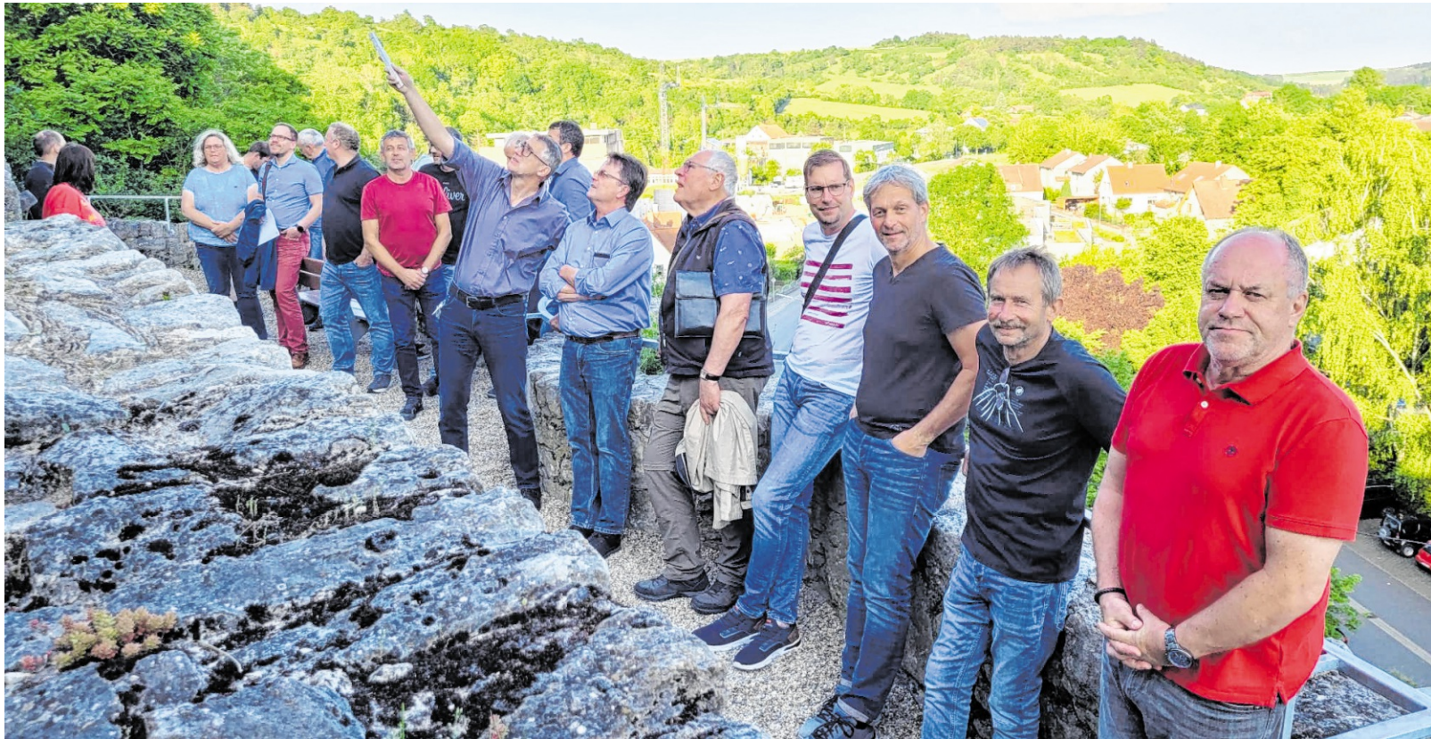
Die Mitglieder des Grünsfelder Gemeinderats begutachteten den instandgesetzten Teil der Stadt- und Burgmauer.
