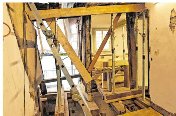
Durch das Dach ist Wasser in den Übergang zwischen Wand und Erker eingedrungen. Die kniffligsten Arbeiten hat der Zimmermann inzwischen erledigt.
