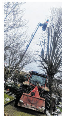
In schwindelnder Höhe wurden Kronensicherungsmaßnahmen von einem Fachmann vorgenommen.
