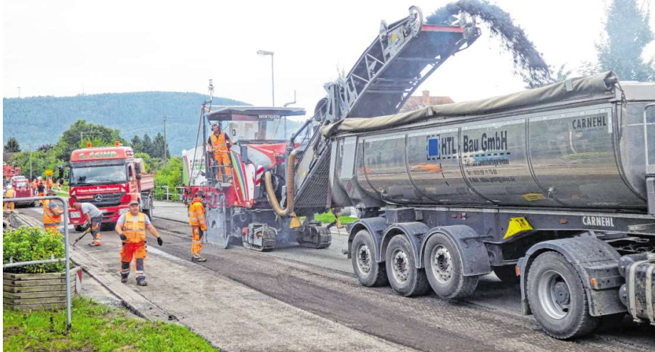
Seit Montag laufen die Arbeiten zur Sanierung der Mondfelder Ortsdurchfahrt. Mit Hilfe einer hochmodernen Fräse wird aktuell der Fahrbahnbelag abgetragen. BILDER: GREIN
