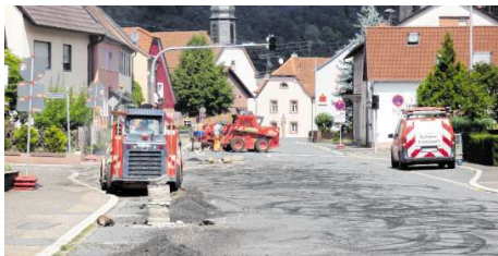
Zur Vorbereitung der Sanierung wurden die Einbauteile in der L 2310, wie Schachdeckel und Hydrantenkappen, entfernt.
